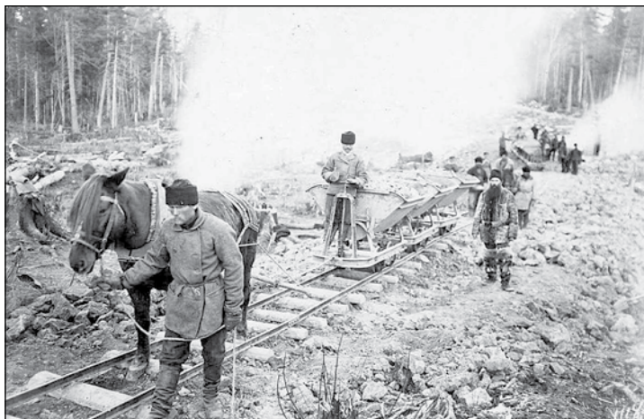
Строительство дороги шло интенсивно...
